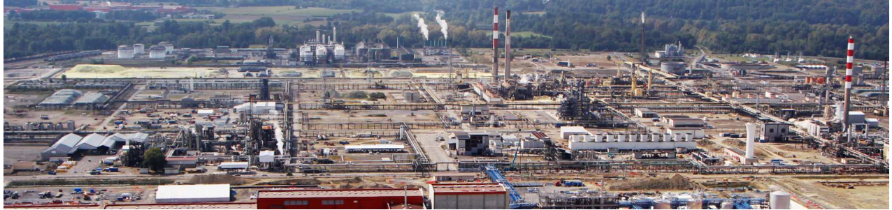
Figure 52 : Plateforme INDUSLACQ – Un paysage industriel
